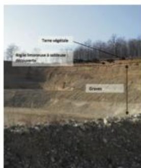
Coupe de la carrière exploitée
