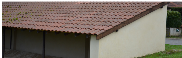
Après les travaux
