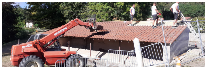
Pendant les travaux
