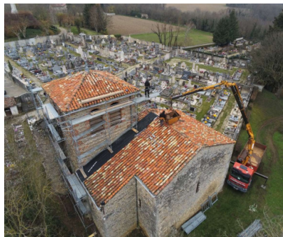
Photo prise par drone - Entreprise CHARRION
