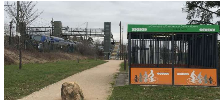
Consigne vélo 3CM à proximité de la gare de Montluel
