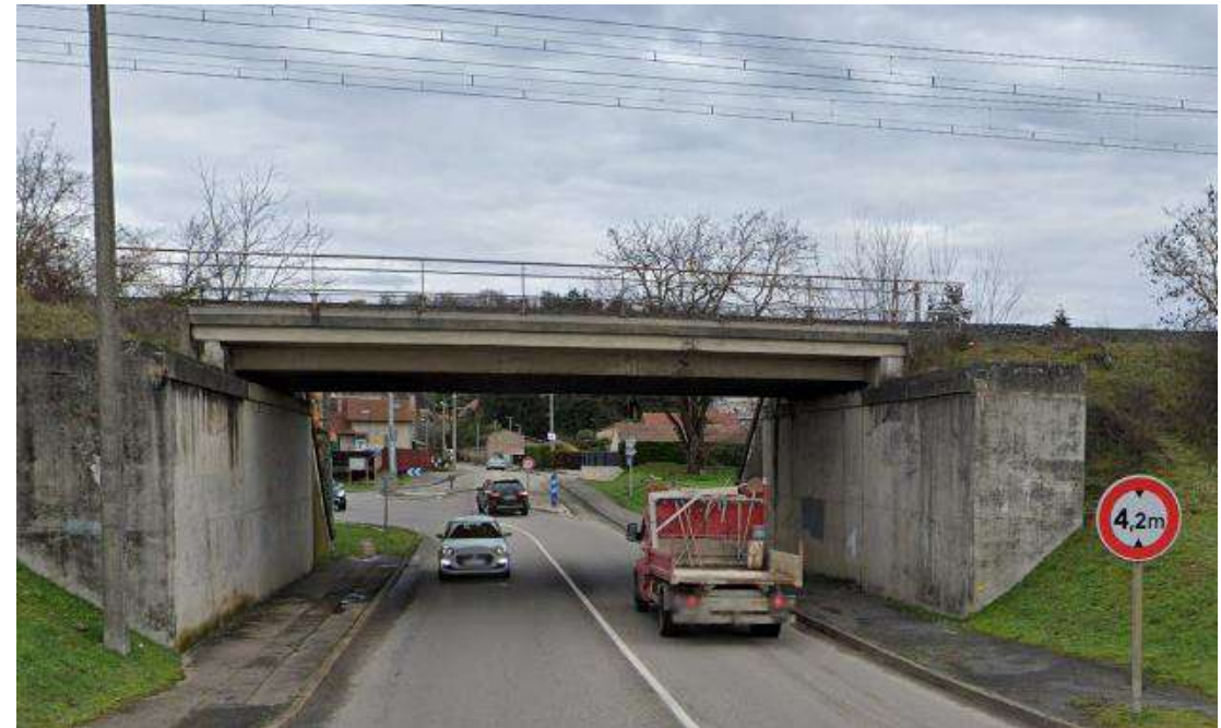
Traversée de la voie ferrée - Dagneux
