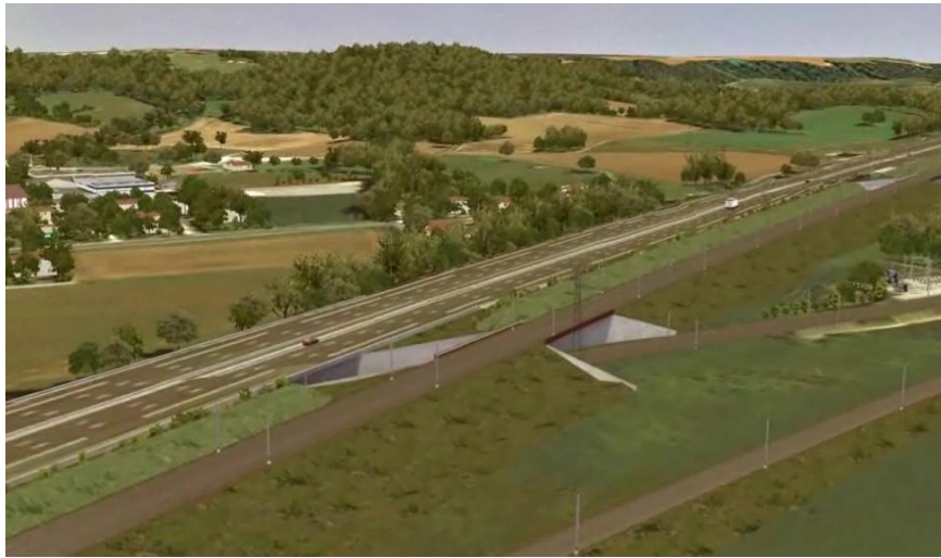
Absence de protection au niveau du franchissement de l'ouvrage
